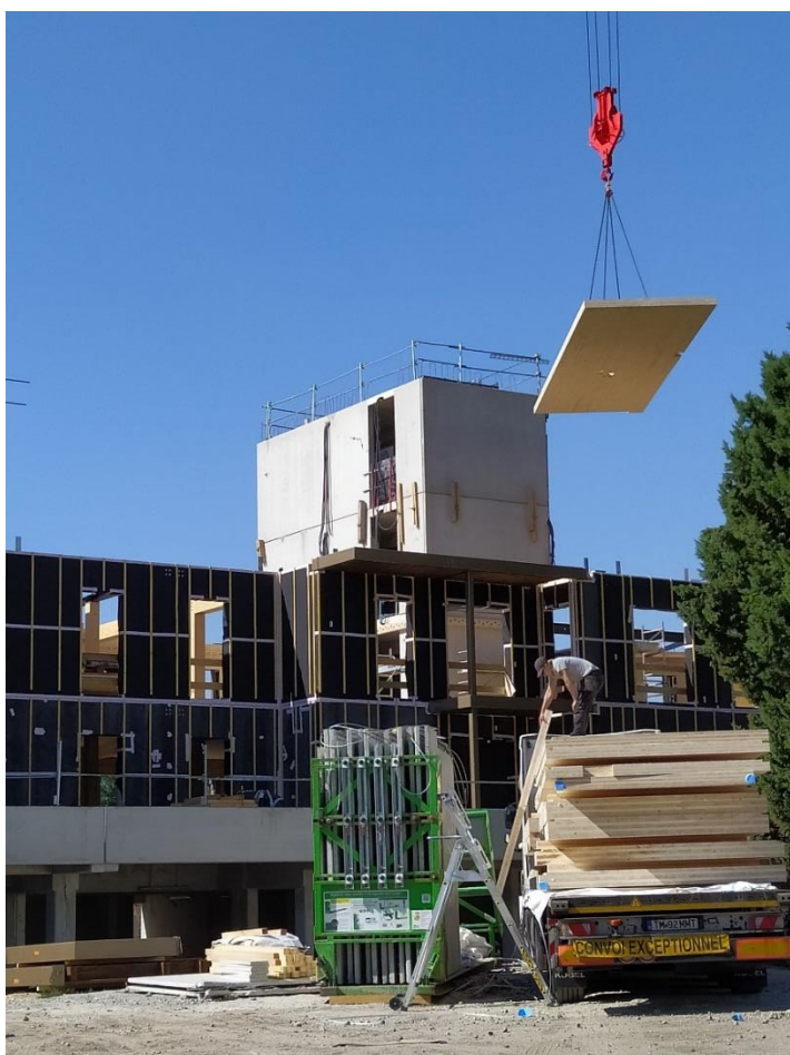
52 logements en ossature bois avenue Stalingrad. MOA Woodeum– Architecte : WOA
