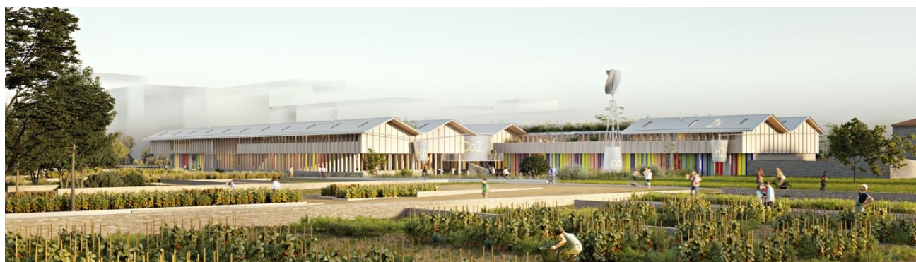
Groupe scolaire à Stains. MOA : Plaine Commune Développement – Architecte : SOA
